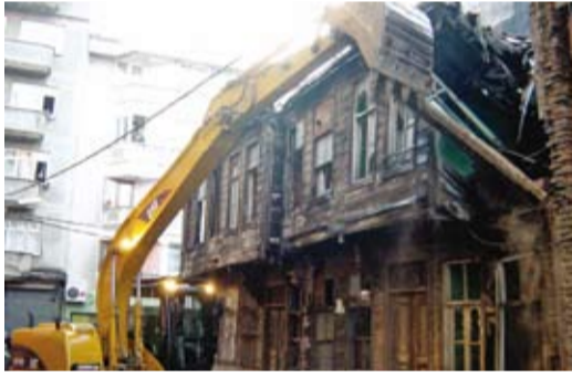
Tavani çöken metruk bina vinç yardımıyla yıkıldı.
